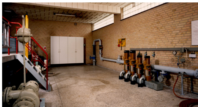
Udpumpning efter renovering i 1991
