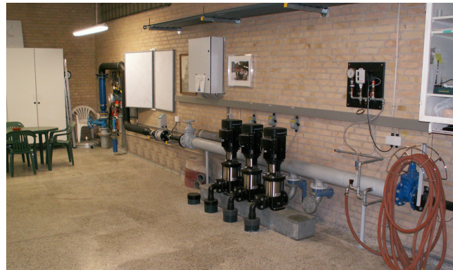
Udpumpning efter renovering i 2006
